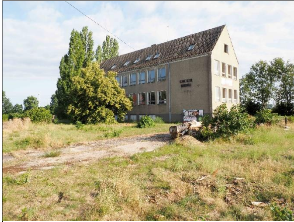
Foto 1: Ehemaliges Schulgebäude und Freiflächen
