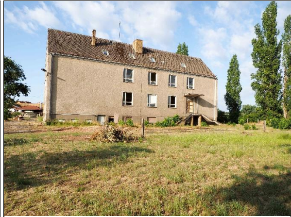
Foto 2: Ehemaliges Schulgebäude und Freiflächen
